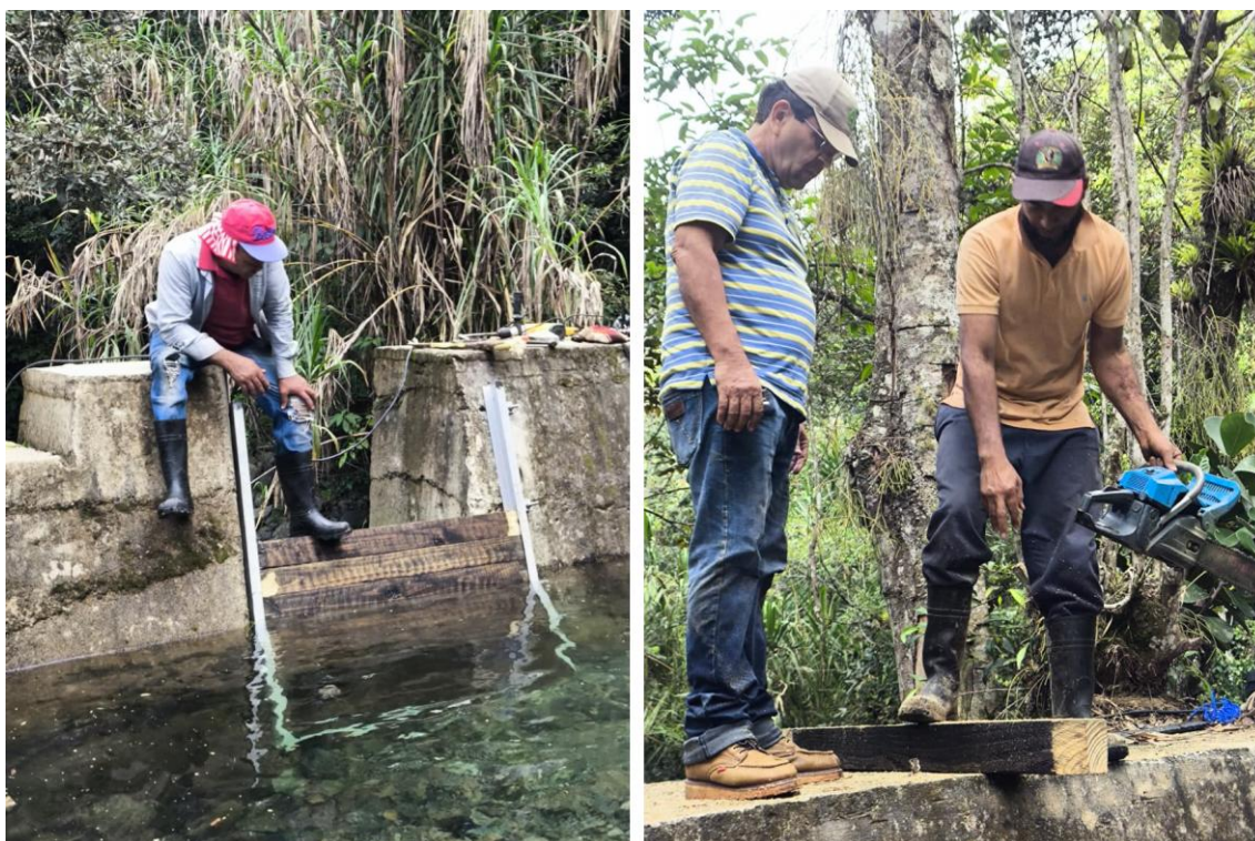
Figura 1. Instalación de compuerta en la obra de toma de la microhidroeléctrica La Yuca – Florencio.
