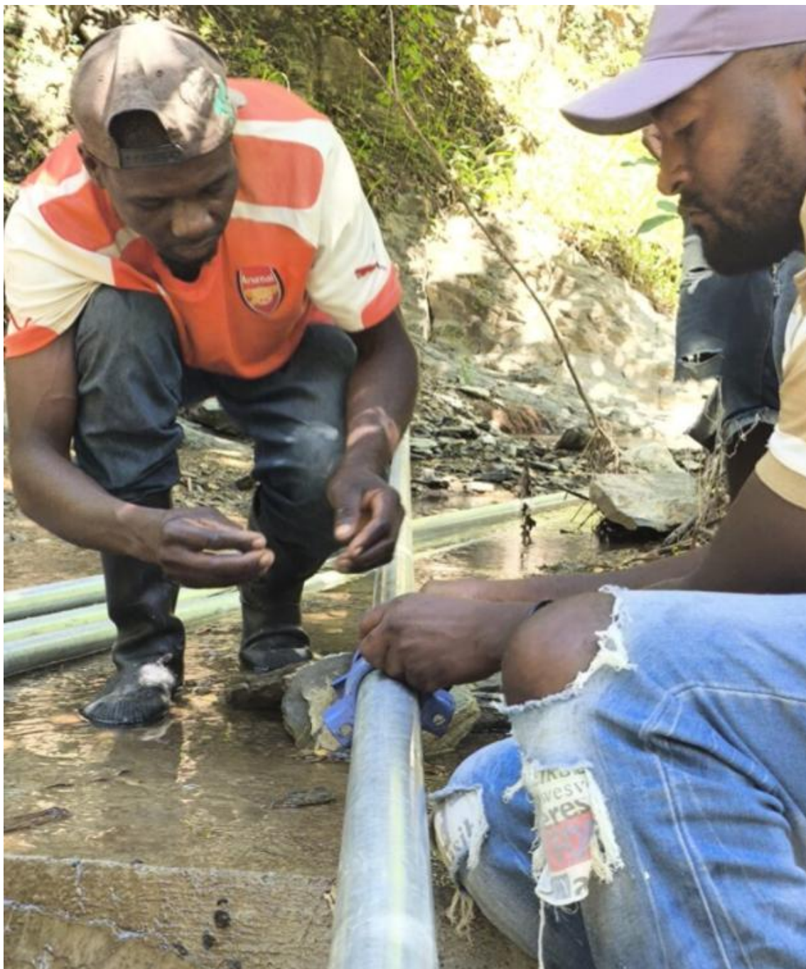
Figura 9. Trabajos de instalación del acueducto en El Corte (Cerca-la-Source, Haití).
