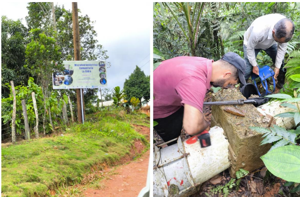
Figura 3. Microhidroeléctrica La Cidra. A la derecha, uno de los momentos de los trabajos de mejora de la tubería.
