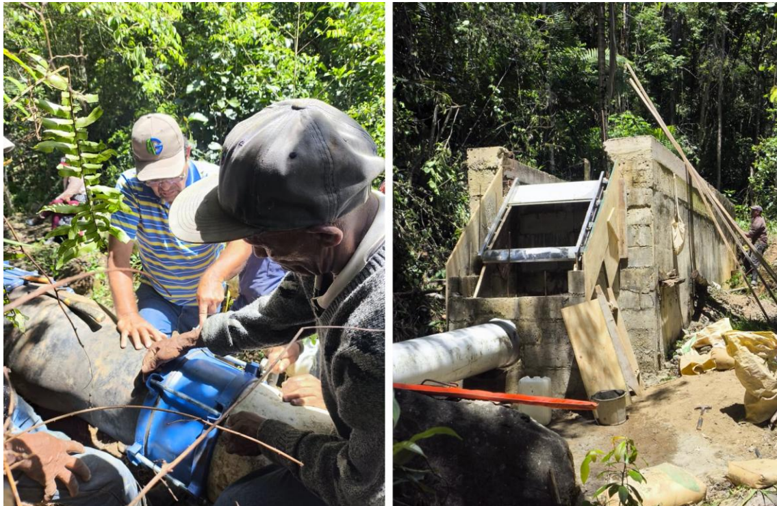
Figura 2. Microhidroeléctrica La Yuca – Florencio: trabajos en la tubería (izquierda) y en el desarenador (derecha).
