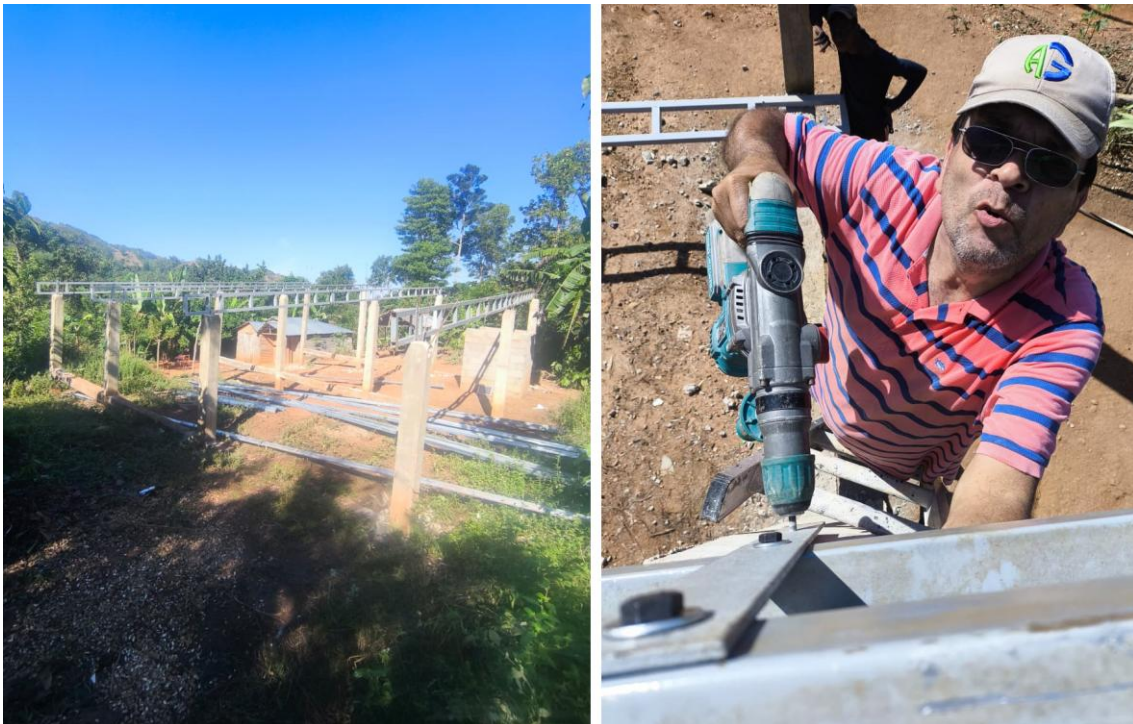
Figura 8. Trabajos de instalación de primer núcleo solar fotovoltaico en Chambelan (Fort Liberté, Haití).
