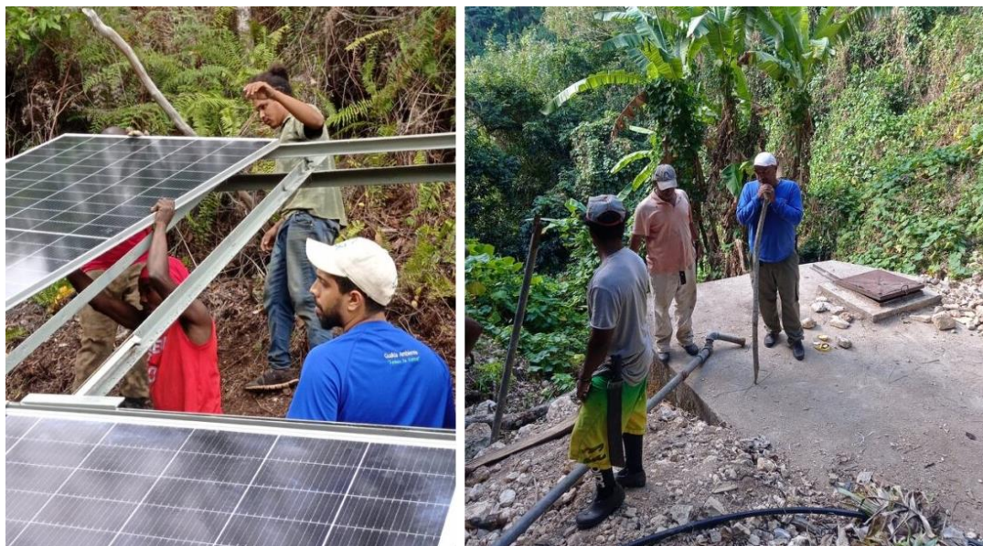
Figura 5. Momentos de la construcción del acueducto comunitario de La Malanga - Leonardo, impulsado por bombeo solar fotovoltaico.
