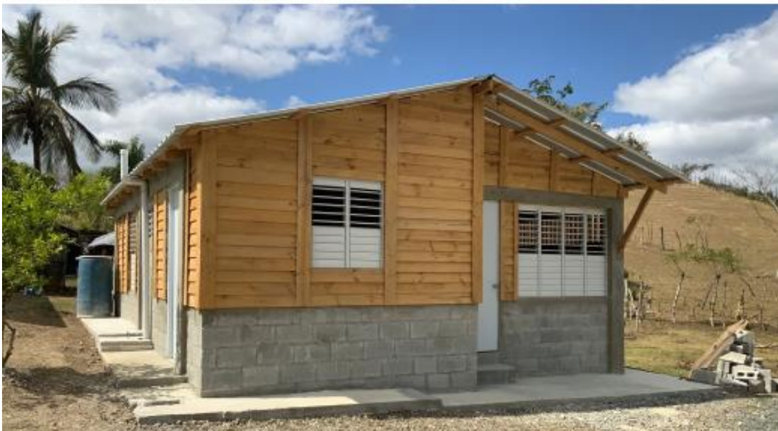
Figura 5. Una de las viviendas construidas y terminadas en las comunidades de Las Tunas y Dos Bocas: casa de Martín.
