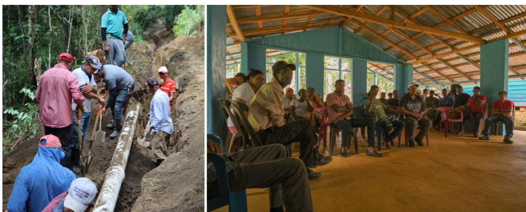
Figura 3. Instalación de tubería en Angostura (izquierda) y reunión comunitaria en La Cidra (derecha).
