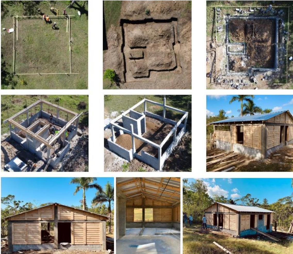
Figura 5. Proceso constructivo de las viviendas en las comunidades de Las Tunas y Dos Bocas.
