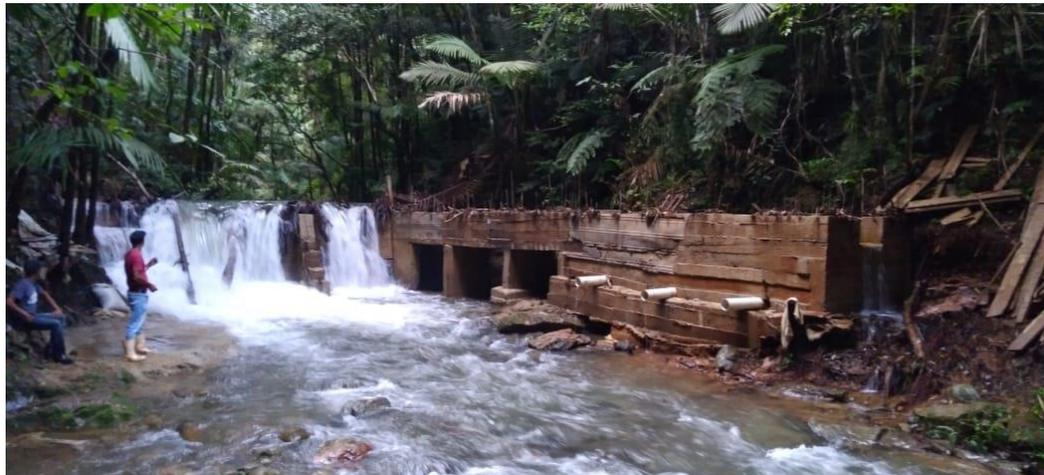
Figura 4. Progresos en la construcción de la obra de toma y el desarenador de la microhidroeléctrica comunitaria La Cidra.
