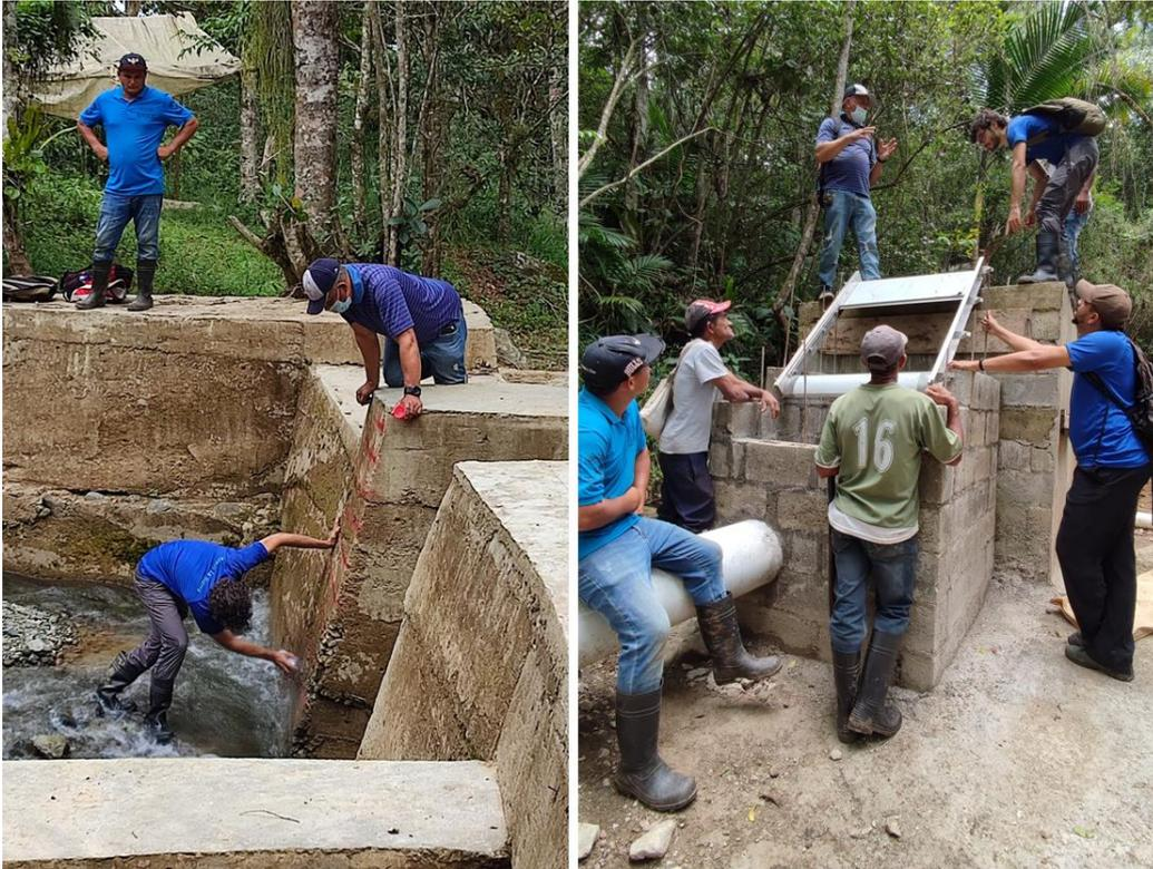
Figura 3. Progresos en la construcción de la obra de toma y el desarenador de la microhidroeléctrica comunitaria La Yuca - Florencio.
