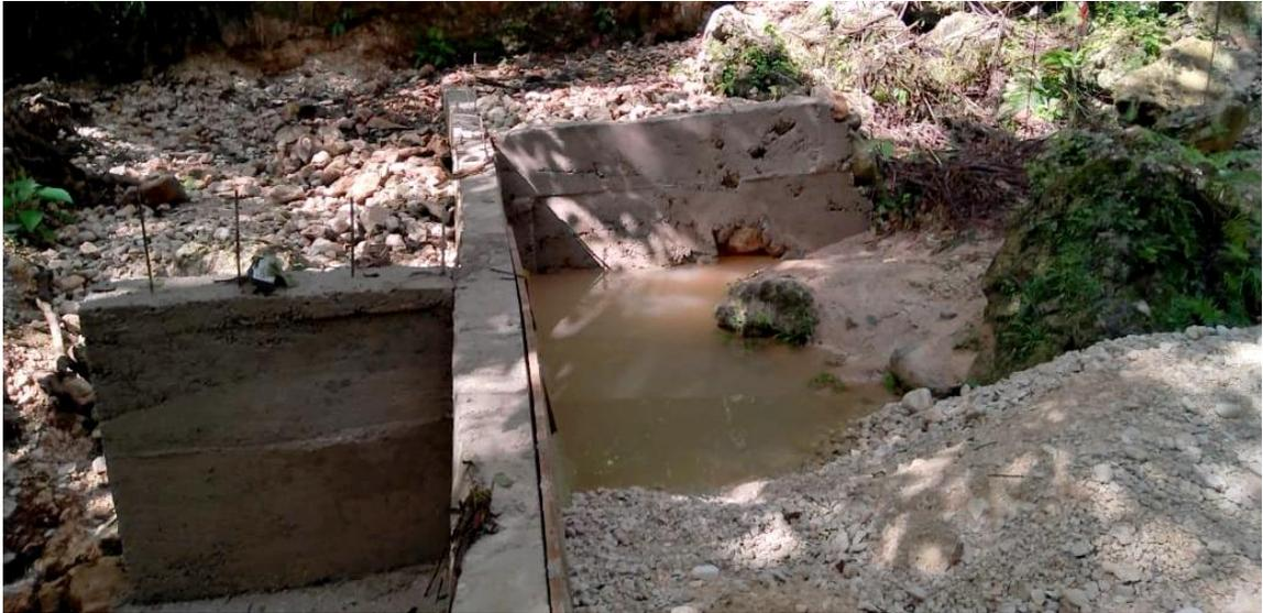
Figura 3. Detalle de la construcción de la obra de toma de la microhidroeléctrica La Malanga.
