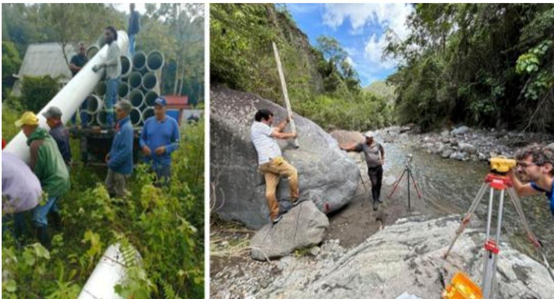
Figura 2. Llegada de parte de la tubería de la microhidroeléctrica El Recodo (izquierda) y mediciones topográficas en la fuente de agua aprovechada para la generación (derecha).
