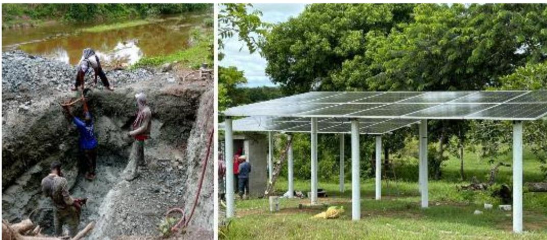
Figura 5. Ampliación del acueducto de Las Tunas – Las Dos Bocas – EL Cerrito: trabajos de construcción de la obra de toma en el Río Anamá (izquierda) y sistema fotovoltaico para el bombeo del agua (derecha).
