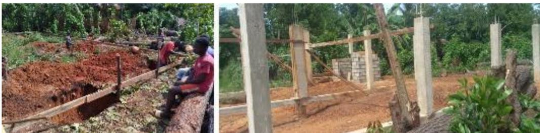
Figura 7. Construcción de la estructura de soporte del primer núcleo fotovoltaico en la comunidad de Chambelan.
