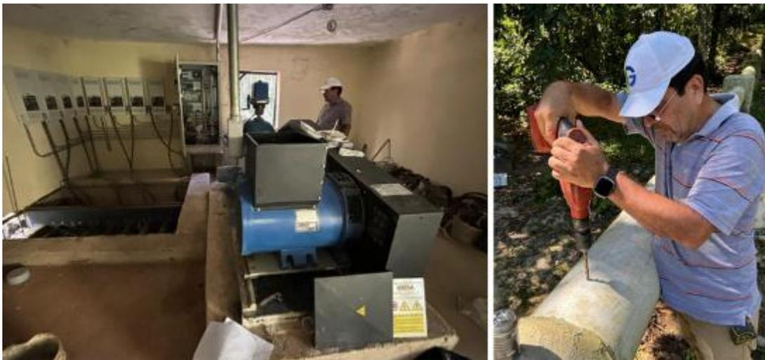
Figura 4. Sistema de generación de la microhidroeléctrica Los Montazos (izquierda) y trabajos en la línea de tubería (derecha).
